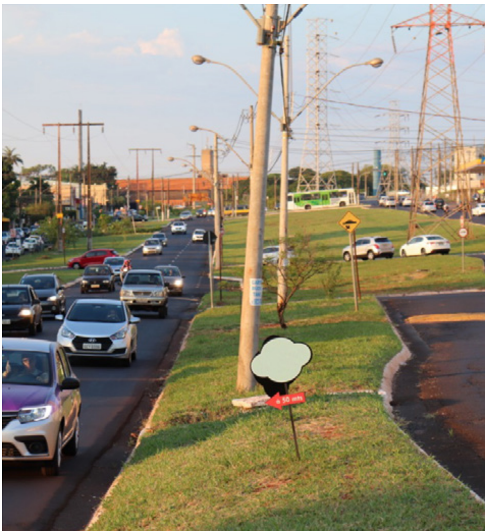
Em horários de pico, trânsito é intenso na Avenida Leão XIII
