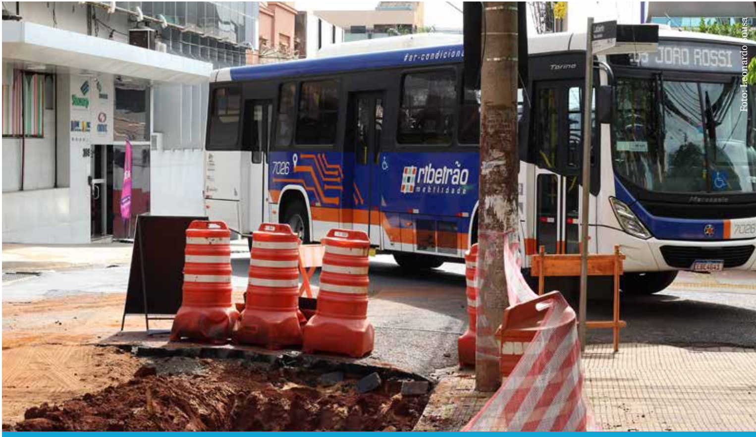
Obras no quadrilátero central de Ribeirão Preto dificultam a circulação do transporte público, carros, motos e pedestres
